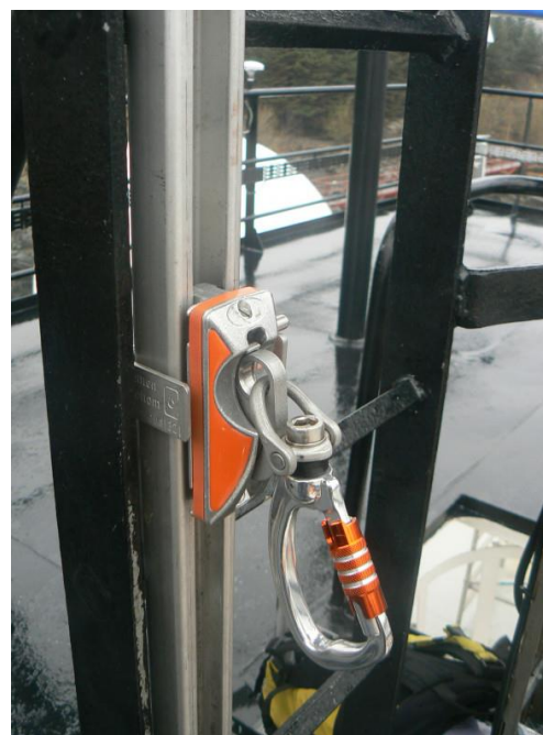
Figure 16 : Exemple d'un Rail et d'un système antichute SÖLL
