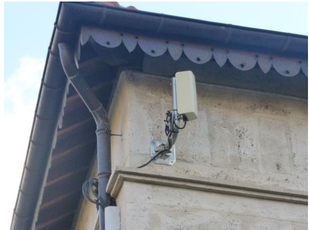
Figure 17 : Vue rapprochée de l'antenne micro du site SMC_HAUTERIVES
