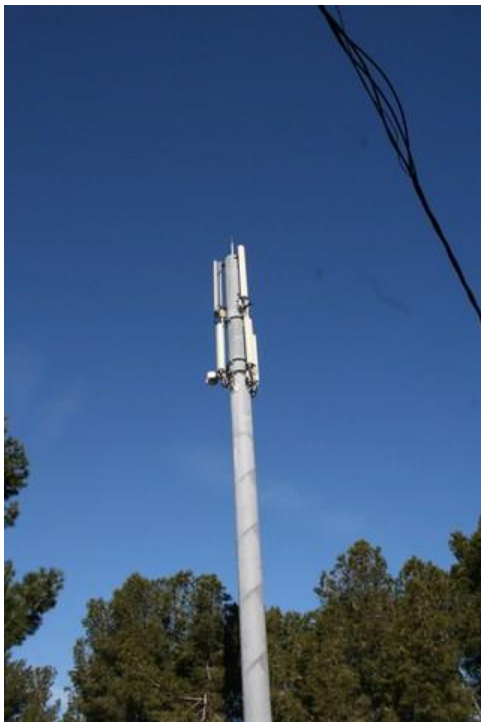
Figure 14 : Vue d'ensemble du pylône LA_COURONNE_STADE
